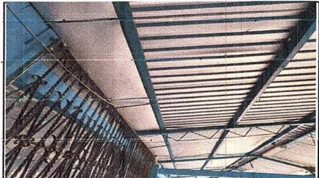
módulo 1 instalación de canal
