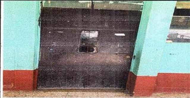
Foto 1 Módulo 1 sustitución de puertas
