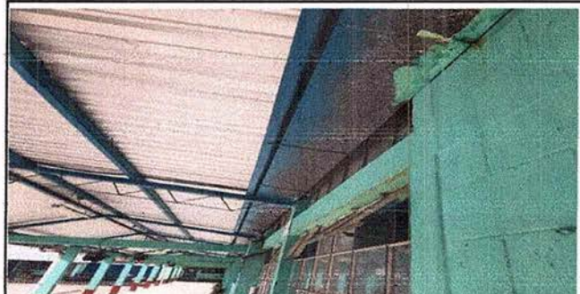
Foto 2 Módulo 1 sustitución de canal
