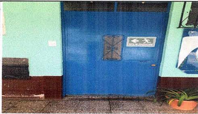
Foto 3: Módulo 2 sustitución de puerta
