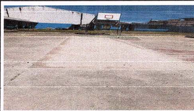
cancha polideportiva: fundición de concreto
