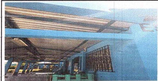
módulo 2 instalación de canal
