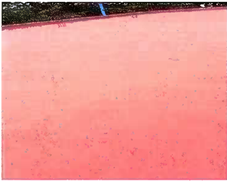
Foto 3: Modulo 6, Impermeabilización de losa
