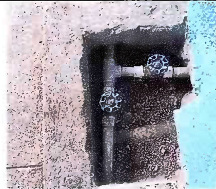
Foto 4 : Modulo 6, Sustitución de llave de cheque
