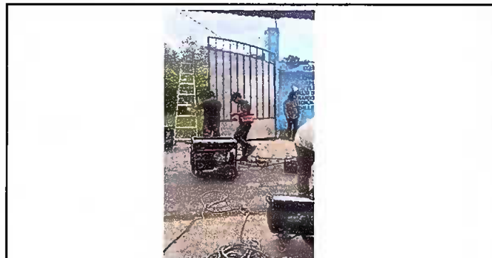
Foto 1: Muro Perimetral, sustitución de portón de metal de ingreso
