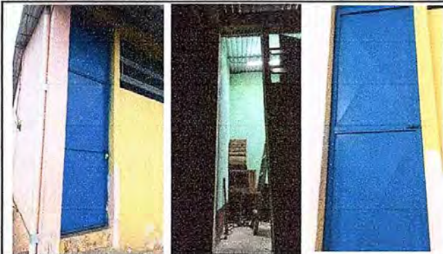
Foto 13: modulo II, sustitucion de puerta
