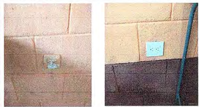
Foto 20: modulo III, Sustitucion de toma corrientes.
