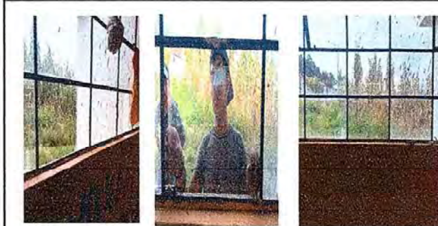
Foto 6: modulo I, Sustitución de vidrio.
