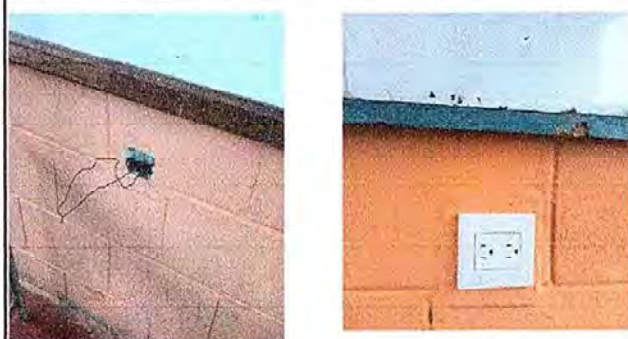
Foto 2: modulo I, Sustitucion de toma corriente.
