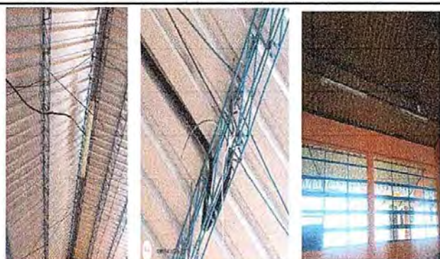
Foto 9: modulo II, Reparación de cableado electrico, sustitucion de ducto electrico mas accesorios, sustituciones de lamparas led e instalaciones de unidades de luz.
