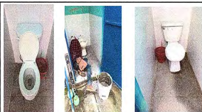
Foto 16: modulo II, Sustitucion e instalacion de inodoros.
