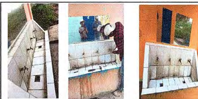
Foto 17: modulo II, Sustitucion e instalacion de chorros.
