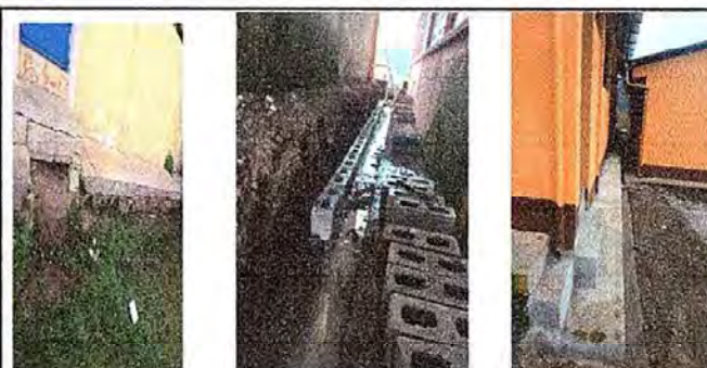
Foto 18: modulo II, Reparacio de banqueta concreto (incluye muro pineado)
