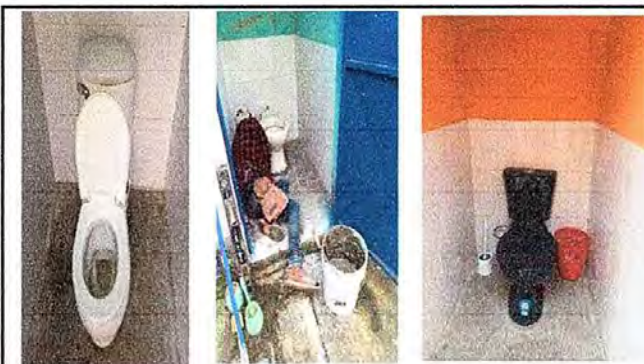
Foto 15: modulo II, Sustitucion e instalacion de inodoros
