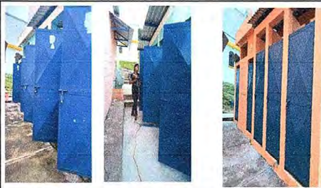
Foto 14: modulo II, mantenimiento de puertas (lijado, cambio de tubo, cepillado, sujeciones.) Aplicaciones de pintura a puertas de servicios
