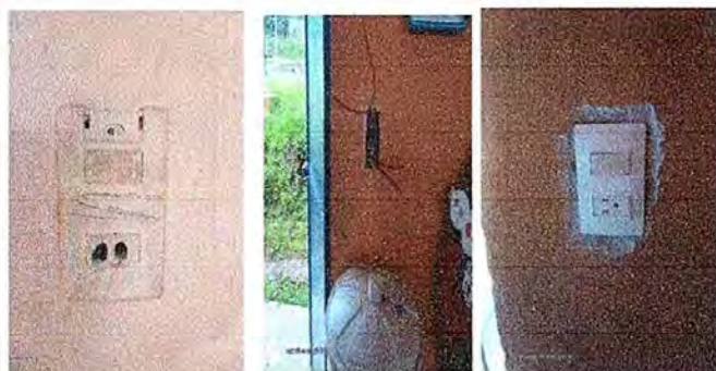
Foto 11: modulo II, Instalacion de interruptores dobles
