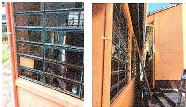
Foto 27 : modulo III, Sustitucion de vidrios.
