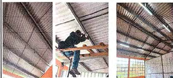
Foto1: modulo I, Reparacion del cableado electrico, sustitucion de ducto electrico mas accesorios, sustitución de lamparas led y instalaciones de unidades de luz.
