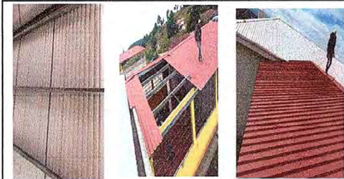
Foto 5: modulo I, Cubierta de LaminaSustitucion de lamina por lamina troquelada aluzinc calibre 26, elementos de fijación (tornillos), desinstalacion e instalación.
