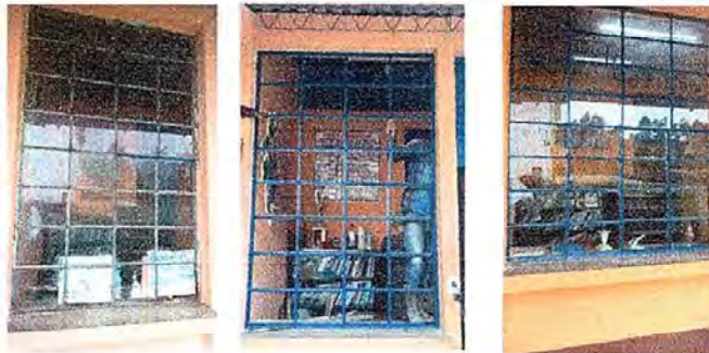
Foto 12: modulo II, sustitucion de estructura de metal de ventana y sustitucion de vidrios
