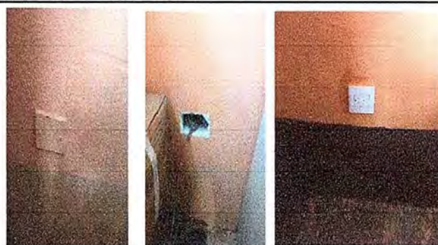
Foto 10: modulo II, Sustitucion de toma corrientes.
