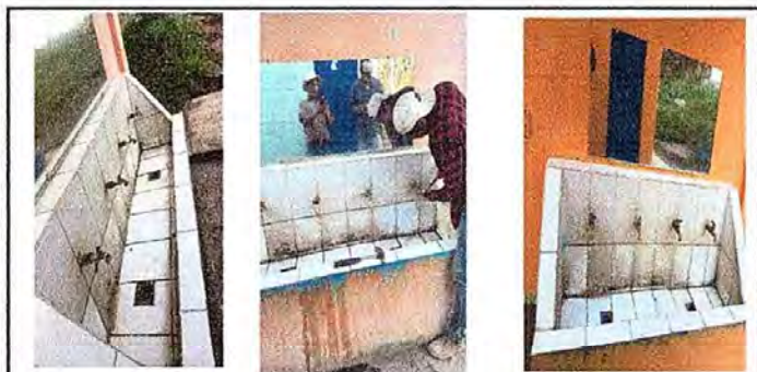
Foto 17: modulo II, Sustitucion e instalacion de chorros.
