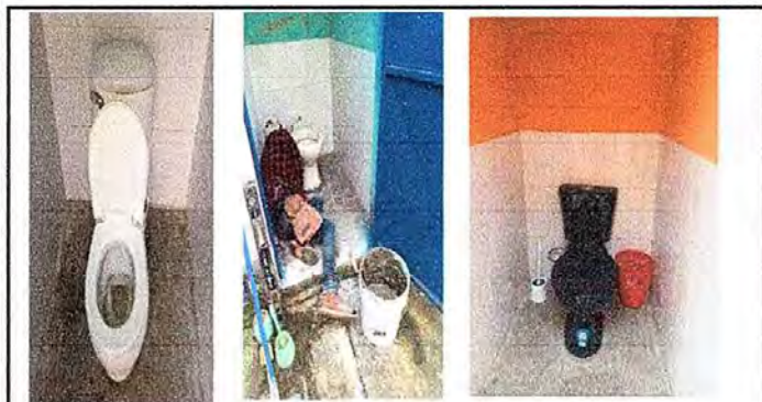
Foto 15: modulo II, Sustitucion e instalacion de inodoros
