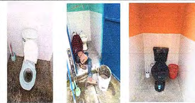
Foto 23: modulo III, Sustitucion e instalacion de inodoros.
