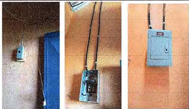
Foto 7: modulo II, Sustitucion de tablero de flipones e instalacion de tablero de flipones, sustitucion e instalaciones flipones.
