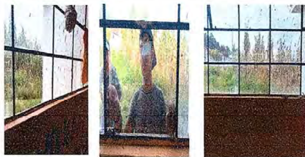
Foto 6: modulo I, Sustitución de vidrio.
