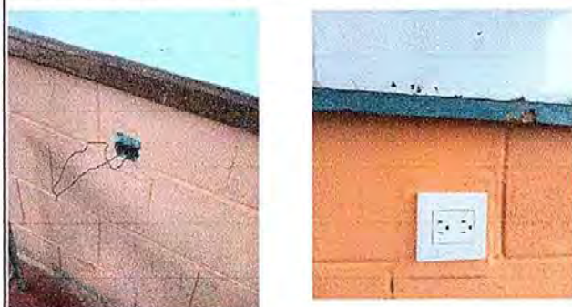
Foto 2: modulo I, Sustitucion de toma corriente.
