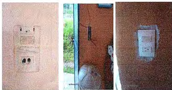
Foto 11: modulo II, Instalacion de interruptores dobles
