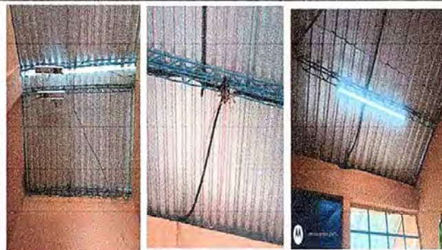
Foto 8: modulo II, Reparación de cableado electrico, sustitucion de ducto electrico mas accesorios, sustituciones de lamparas led e instalaciones de unidades de luz.
