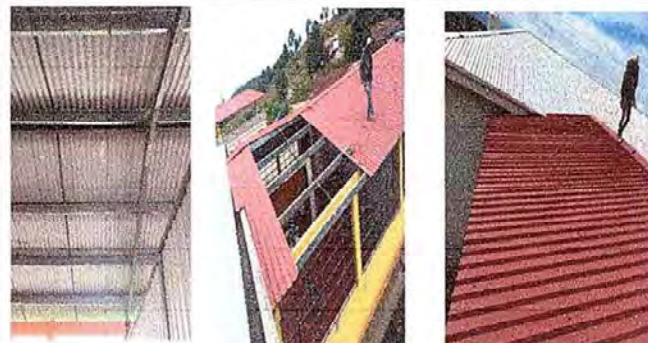
Foto 4: modulo I, Cubierta de LaminaSustitucion de lamina por lamina troquelada aluzinc calibre 26, elementos de fijación (tornillos), desinstalacion e instalación.
