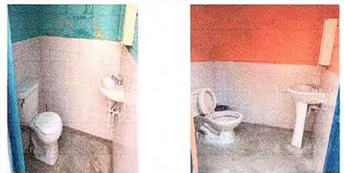
Foto 24: modulo III, sustitucion e instalacion de lava manos.
