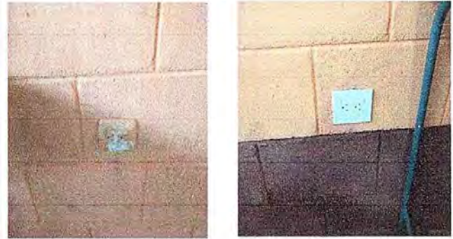
Foto 20: modulo III, Sustitucion de toma corrientes.
