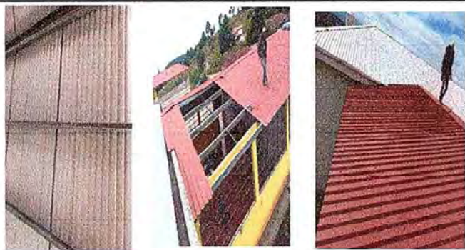
Foto 5: modulo I, Cubierta de LaminaSustitucion de lamina por lamina troquelada aluzinc calibre 26, elementos de fijación (tornillos), desinstalacion e instalación.
