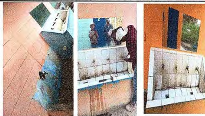
Foto 26 : modulo III,Sustitucion e instalacion de llaves de chorros.
