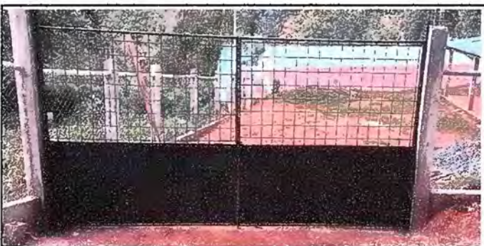
Foto 5: sustitucion de lamina por porton de metal
