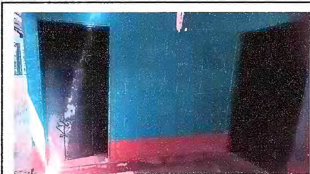
Foto1: mantenimiento de estructura
