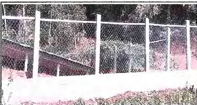
Foto 3: sustitucion de cerco o muro perimetral
