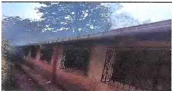
Foto 6: sustitucion de canal PVC
