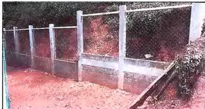
Foto 3: sustitucion de cerco o muro perimetral
