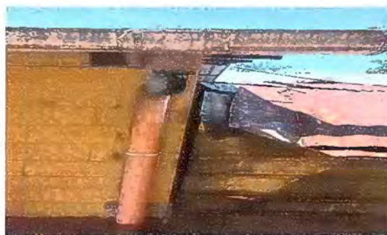
foto 4 sustitucion de bajada de agua
