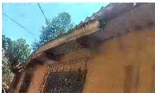
foto 5 sustitucion de Canal PVC
