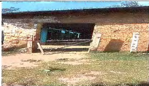
Foto1: sustitucion de puerta de maya por porton de metal (sobre las columnas)
