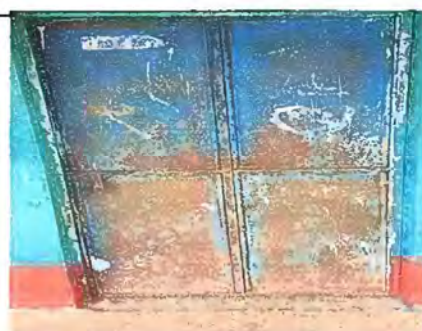
foto 6 Mantenimiento a estructuras
