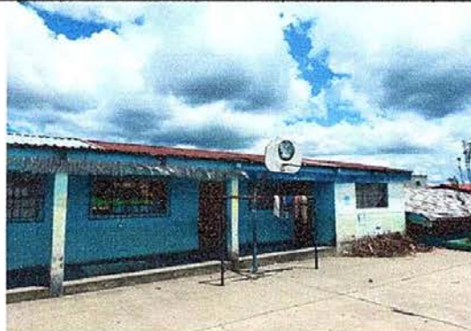
Foto 2: Sustrucción de lámina, por lámina troquelada aluzinc calibre 26, módulo No. 2
