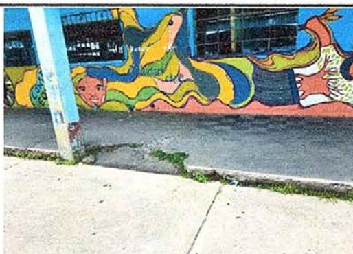
Foto 4: Reparación de banquetas de concreto, módulo No. 1
