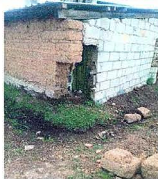
Foto 8: Reparación de muro de block de baño, módulo 3
