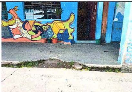
Foto 3: Reparación de banquetas de concreto, módulo No. 1
