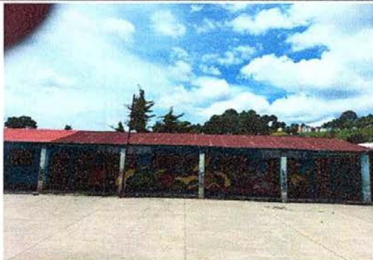
Foto 1: Sustrucción de lámina, por lámina troquelada aluzinc calibre 26, módulo No. 1
