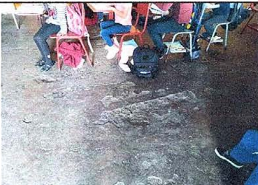
Foto 5: Reparación de piso de cemento líquido, módulo No. 1
