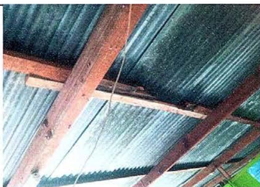
Foto 9: Sustitución de estructura de soporte de madera por metal, módulo No. 1
