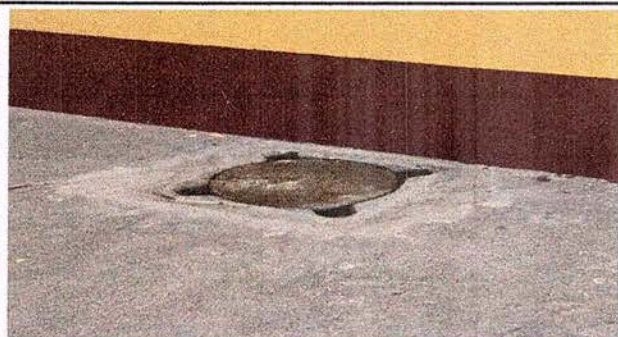
Foto: 9 MODULO 2: SUSTITUCIÓN DE TAPADERA DE DRENAJE
