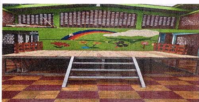
FOTO 11: CAMBIO DE ESTRUCTURA ESEENARIO
