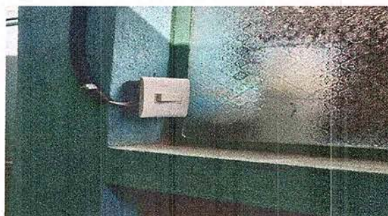
Foto 6: MODULO 1 INSTALACIÓN DE UNIDADES DE LUZ
