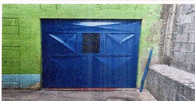
Foto 7: MODULO 1: COCINA SUSTITUCIÓN DE PUERTA DE METAL
