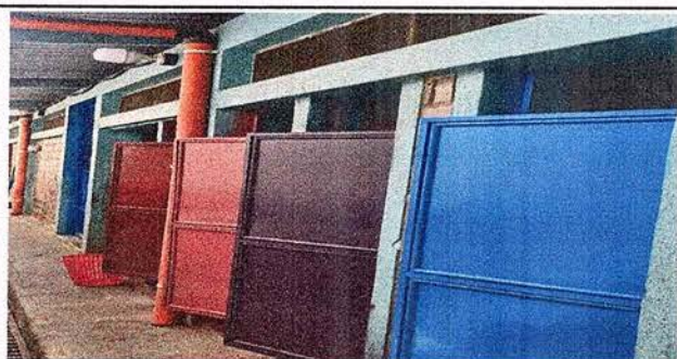
Foto 5: MODULO 1 MANTENIMIENTO DE 7 PUERTAS DE BAÑOS SANITARIOS. Lijado cepillado, aplicación de pintura.
