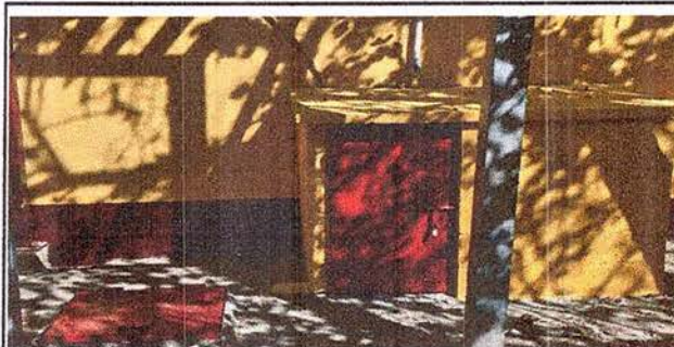
Foto 10: MODULO 2 MANTENIMIENTO A ESTRUCTURA DE PUERTA LIJADO, CEPILLADO, APLICACIÓN DE PINTURA
