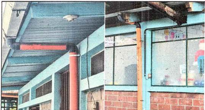
Foto 15: MODULO 3 PATIO Reparación de cableado eléctrico, sustitución ducto eléctrico más accesorios, Sustitución plafoneras (caja octagonal), Sustitución focos ahorradores, Instalación de unidades de luz.
