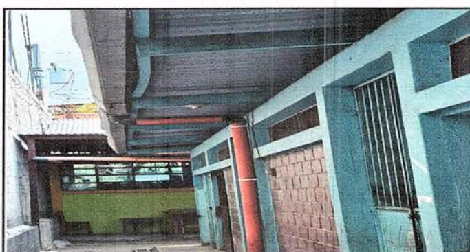
Foto 6: MODULO 1 INSTALACIÓN DE UNIDADES DE LUZ
