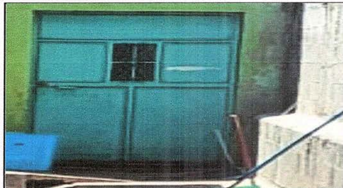
Foto 7: MODULO 1: COCINA SUSTITUCIÓN DE PUERTA DE METAL
