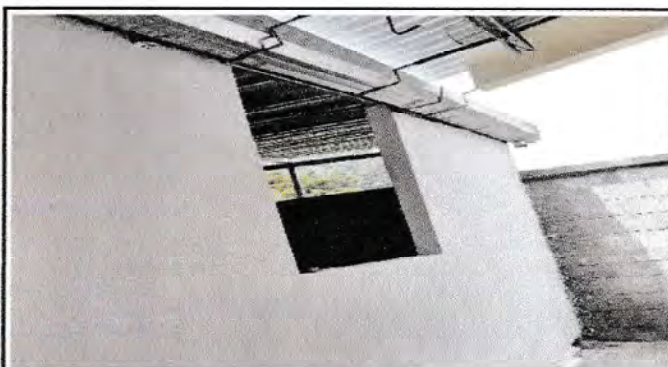
Foto 4: finalización del muro perimetral del aula
