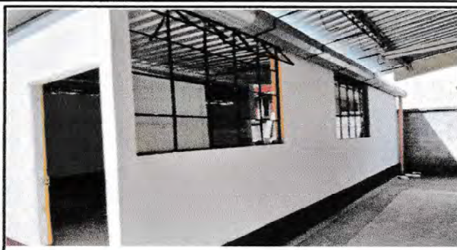
Foto 2: finalización del muro perimetral del aula
