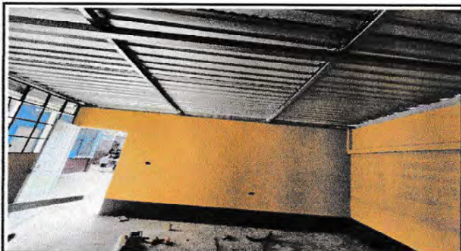
Foto 3: finalización del muro perimetral del aula
