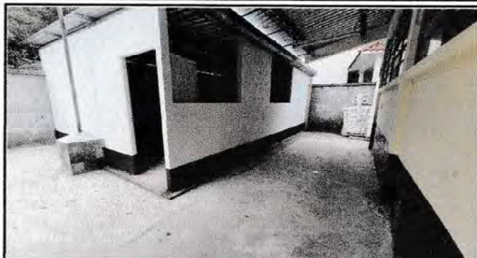
Foto 1: finalización del muro perimetral del aula
