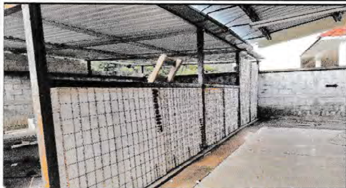
Foto 1: Colocación de muro perimetral en Aula
