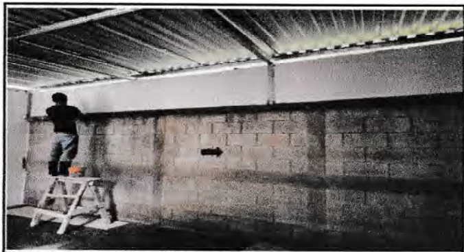
Foto 3: Colocación de muro perimetral en Aula
