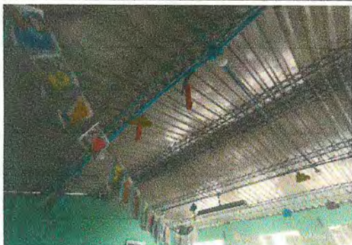
Foto 3: M REPARACIÓN /SUSTITUCION/ MANTENIMIENTO DE CUBIERTA DE LÁMINA. Sustitución de lámina, por la lámina troquelada calibre 26
