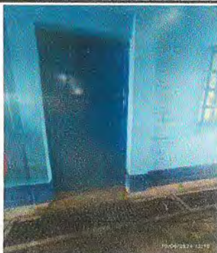
Foto 5: MANTENIMIENTO A ESTRUCTURA. aplicación de pintura en puertas
