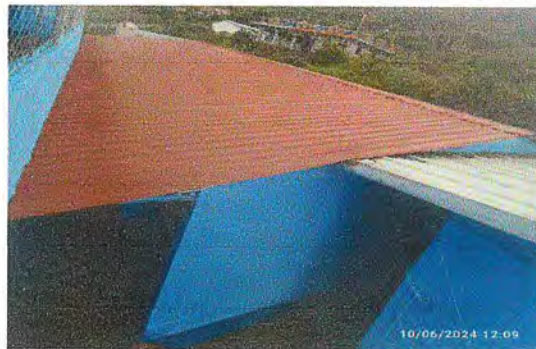
Foto 4: REPARACIÓN /SUSTITUCION/ MANTENIMIENTO DE CUBIERTA DE LÁMINA. Sustitución de lámina, por la lámina troquelada calibre 26
