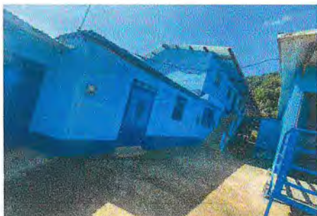
Foto 1: MANTENIMIENTO PINTURA EN MUROS EXTERIORES. Aplicación de pintura en aulas por afuera
