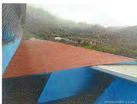
Foto 4: REPARACIÓN /SUSTITUCION/ MANTENIMIENTO DE CUBIERTA DE LÁMINA. Sustitución de lámina, por la lámina troquelada calibre 26
