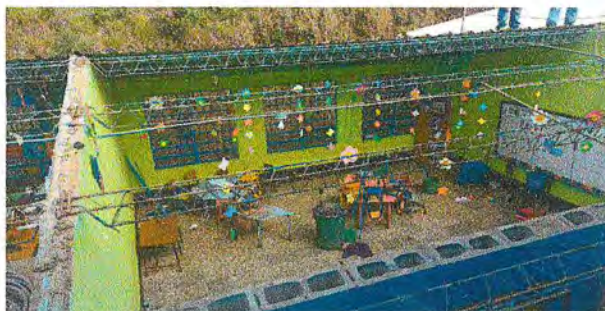
Foto 3: REPARACIÓN /SUSTITUCION/ MANTENIMIENTO DE CUBIERTA DE LÁMINA. Sustitución de lámina, por la lámina troquelada calibre 26
