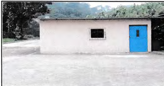
Foto1: Ampliacion de Cocina
