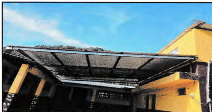
Foto 3: Instalacion de techo.
