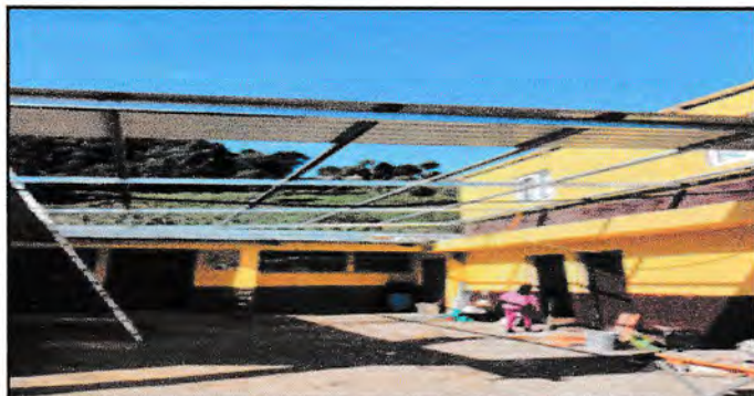
Foto 3: INSTALACION DE TECHO
