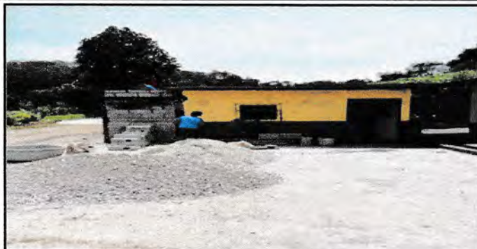
Foto 1: AMPLIACION DE COCINA
