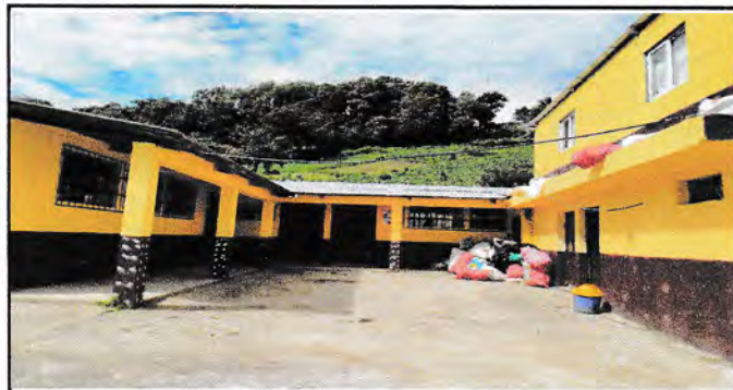
FOTO 3: INSTALACION DE TECHO
