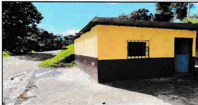
FOTO 1: AMPLIACION DE COCINA
