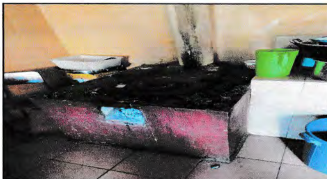
FOTO 4: SUSTITUCION DE ESTUFAS O PLANCHAS DE LEÑA
