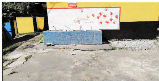
FOTO 5: INSTALACION DE TECHO EN AREA DE LAVAMANOS
