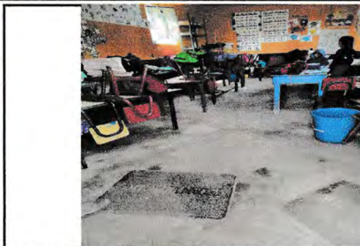
FOTO 2: SUMINISTRO E INSTALACION DE PISO CERAMICO
