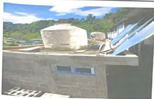
Foto 1: SUSTITUCION DE DEPÓSITO DE AGUA DE 2500 lts
