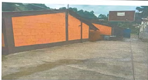
Foto 3: APLICACIÓN DE PINTURA LATEX EXTERIOR
