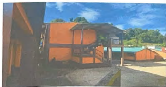
Foto 5: APLICACIÓN DE PINTURA EN BARANDAS
