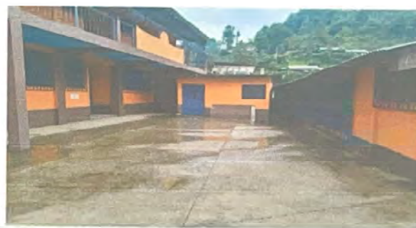
Foto 2: APLICACIÓN DE PINTURA EN PUERTAS
