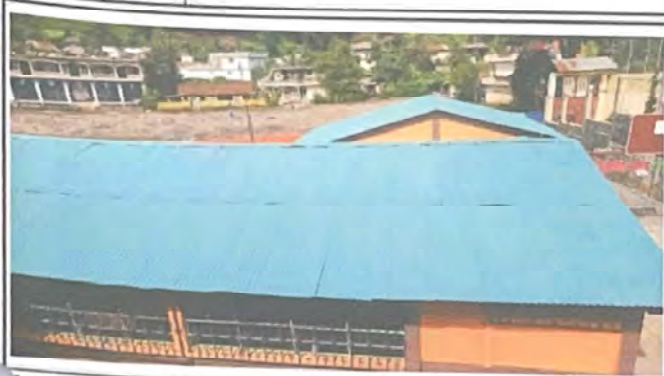
Foto 1: APLICACIÓN DE PINTURA EN TECHO DE LAMINA
