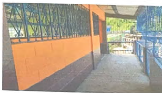
Foto 6: APLICACIÓN DE PINTURA EN BALCONES
