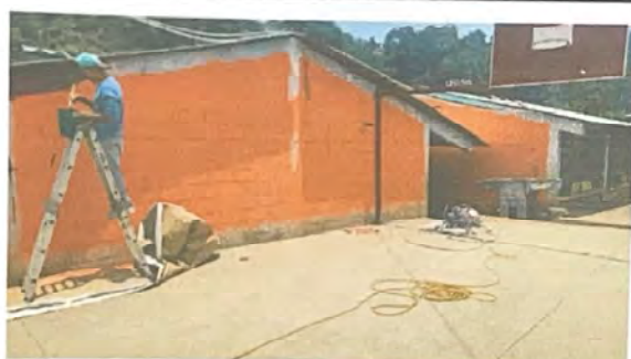
Foto 3: APLICACIÓN DE PINTURA LATEX EXTERIOR
