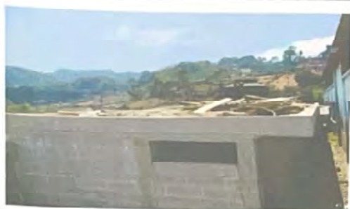
Foto 1: SUSTITUCION DE DEPOSITO DE AGUA
