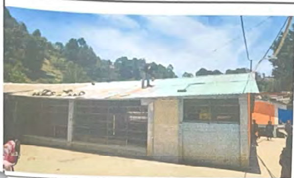
Foto 1: APLICACIÓN DE PINTURA EN TECHO DE LÁMINA
