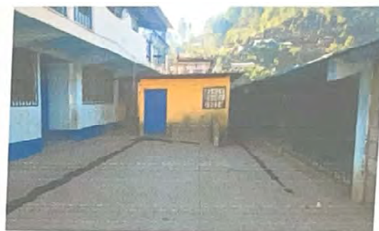
Foto 2: APLICACIÓN DE PINTURA EN PUERTAS
