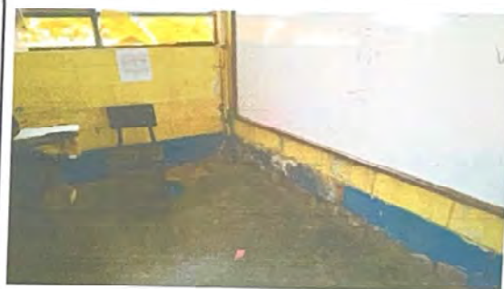
Foto 4: APLICACIÓN DE PINTURA LATEX INTERIOR
