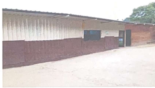
Foto 2: Suministro e instalacion lamina MaxAkum C28 2.70 metro MaxAkum tipo porton, Lamina Troquelada MaxAkum C28 (0.28mm)
