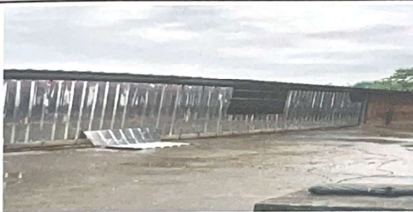
Foto 5: suministro e instalacion estructura metalica costanera 3*2 pulgadas
