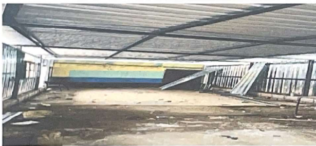
Foto 3: Suministro e instalacion Red Electrica
