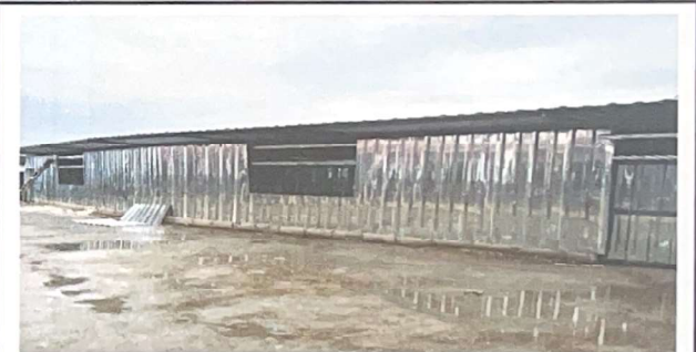
Foto 4: Suministro e instalacion puertas metalicas con chapa Yale
