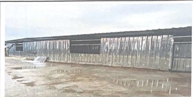
Foto 2: Suministro e instalacion lamina MaxAkum C28 2.70 metro, lamina MaxAkum tipo porton, Lamina Troquelada MaxAkum C28 (0.28mm)
