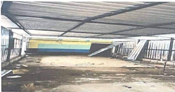
Foto1: Suministro e instalacion electromalla zapatas, fundicion piso.
