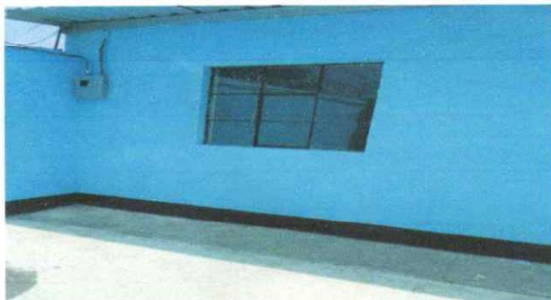
Foto 3: Pintura de exterior
