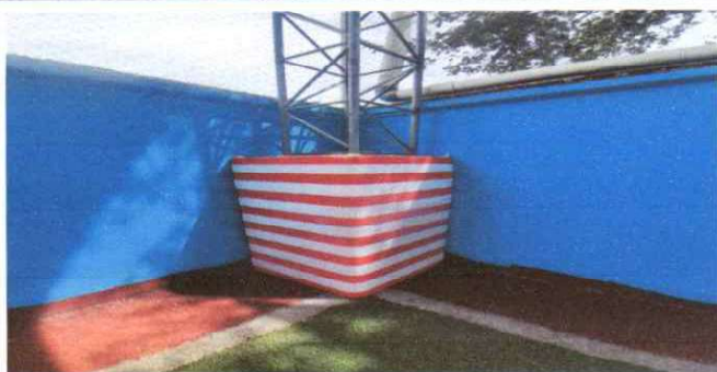
Foto 5: rotores de columnas
