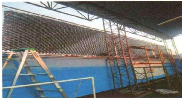
Foto 4: Colocacion de privacinta en maya
