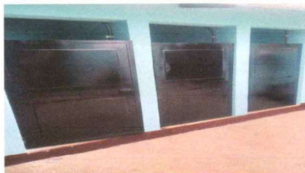
Foto 6 pintura de puertas
