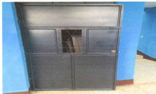
Foto 2: Mantenimiento de estructura metalica
