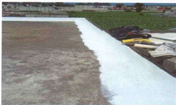
Foto1: Impermeabilización de terraza
