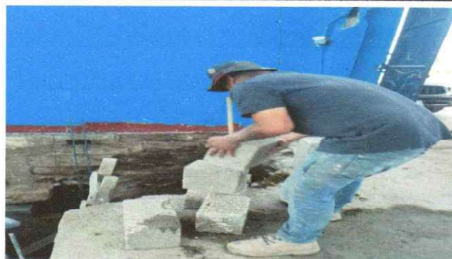
Foto 4: Mantenimiento de sisterna
