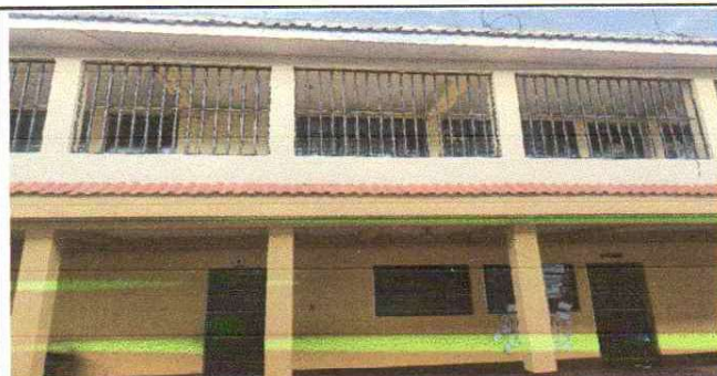
Foto 6: SUSTITUCIÓN DE TEJA DE DURALITA A ARCILLA
