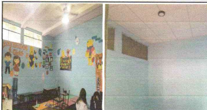
Foto 8: PINTURA DE AULAS, DIRECCIÓN Y CORREDORES EXTERNOS
