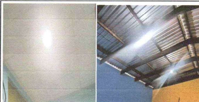
Foto 9: SUSTITUCIÓN, REPARACIÓN Y MANTENIMIENTO DEL SISTEMA ELECTRICO, AULAS Y DIRECCIÓN
