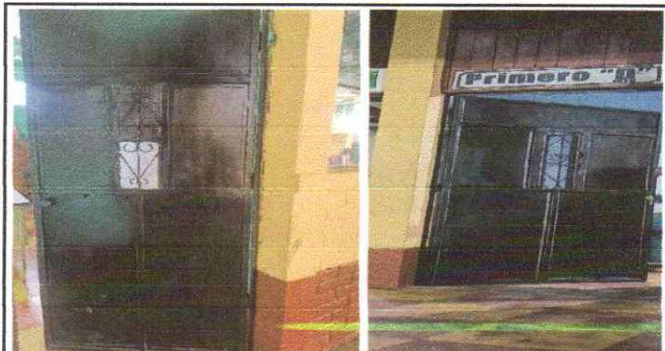
Foto 10: MANTENIMIENTO DE PUERTAS DE AULAS Y DIRECCIÓN CON SUSTITUCIÓN DE CHAPAS Y PINTURA
