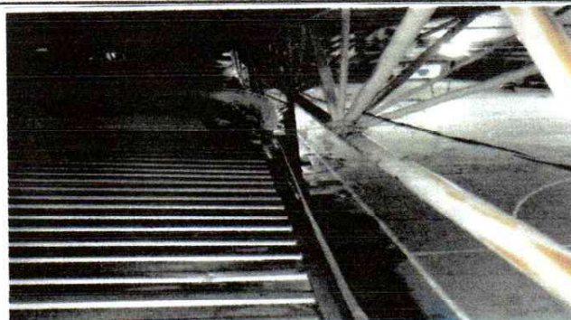
FOTO 2: SUSTITUCIÓN DE CANAL DE METAL DEL TECHO CURVO
