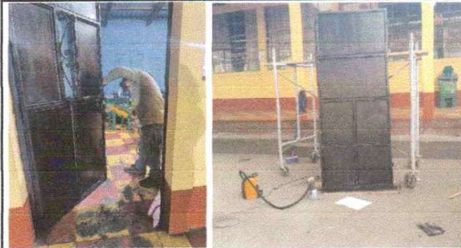
Foto 10: MANTENIMIENTO DE PUERTAS DE AULAS Y DIRECCIÓN CON SUSTITUCIÓN DE CHAPAS Y PINTURA
