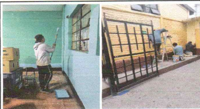
Foto 8: PINTURA DE AULAS, DIRECCIÓN Y CORREDORES EXTERNOS
