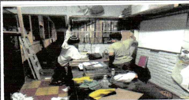
Foto 4: SUMINISTRO E INSTALACIÓN DE ESTANTERÍA FIJA DE BODEGA EN DIRECCIÓN.
