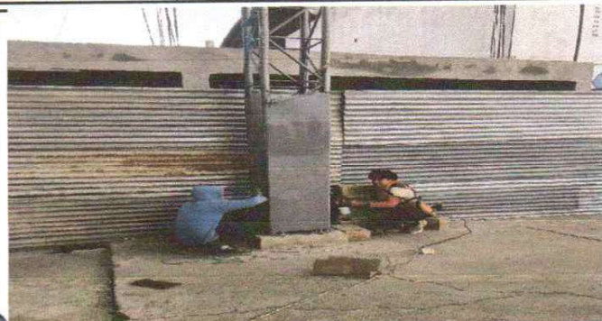
Foto 7: MANTENIMIENTO DE BASES ESTRUCTURALES DE COLUMNAS DE TECHO DEL PATIO CON PINTURA
