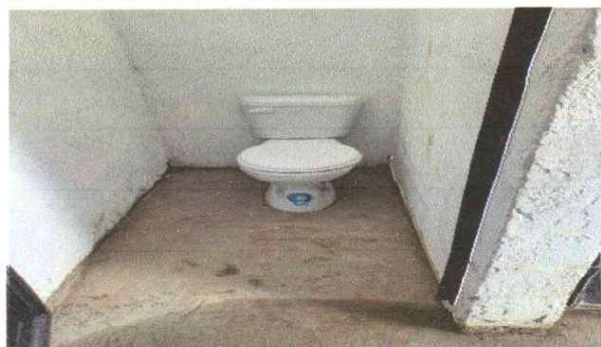
Foto 3: INSTALACIÓN DE BAÑO Y ACCESORIOS.
