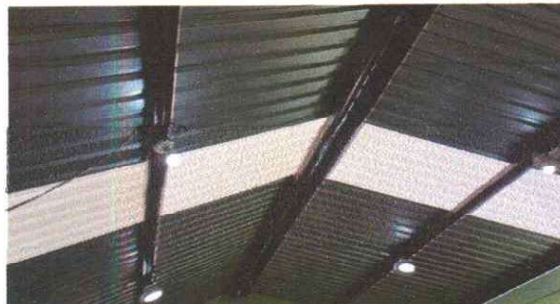
Foto 2: COLOCACIÓN DE BAJADAS DE AGUA. INTERIOR DELAS AULAS CON SUMINISTRO E INSTALACIÓN DE LAMINAS FINALIZADO.
