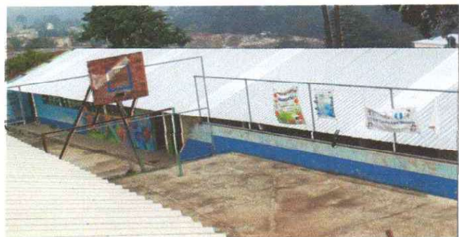
Foto1: VISTA INSTALACIÓN DE LAMINA COLOCADA AL 100%
