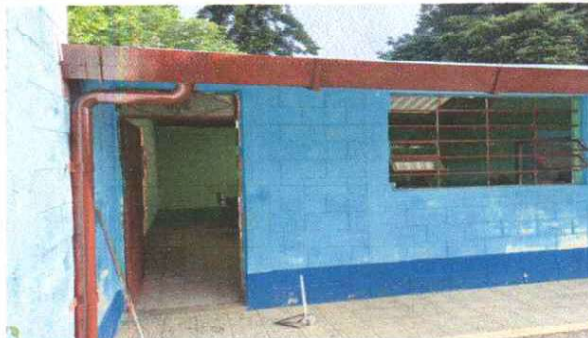
Foto 4: COLOCACIÓN DE BAJADAS DE AGUA.
