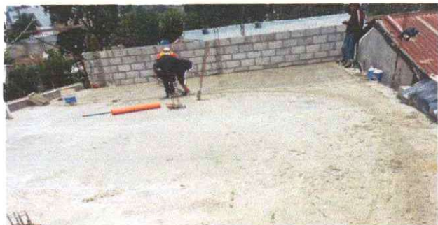
Foto 5: SANACIÓN DE TERRAZA.
