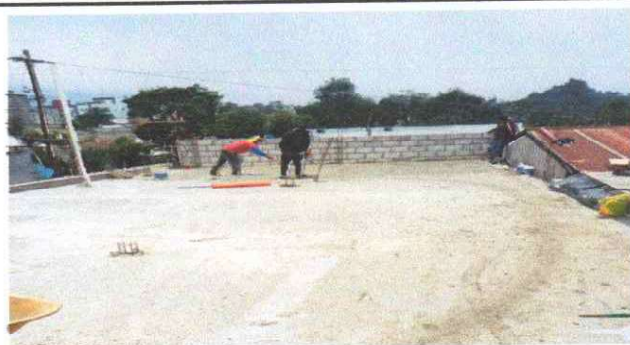
Foto 5: PREPARACIÓN DE LOSA PARA APLICAR IMPERMEABILIZANTE.
