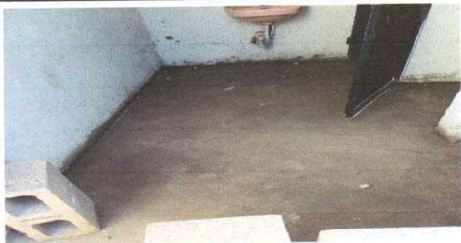
Foto 3: CORRECCIÓN DEL DESNIVEL DE BAÑOS.
