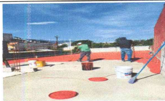
Foto 6: APLICACIÓN DE IMPERMEABILIZANTE.
