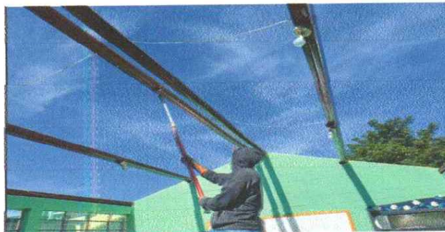
Foto 2: MANTENIMIENTO DE ESTRUCTURA PORTANTE.
