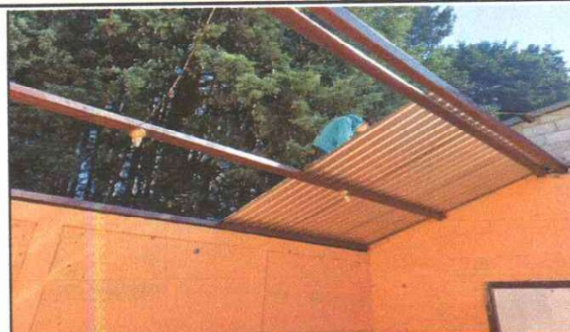
Foto 4: INSTALACIÓN DE LÁMINA.
