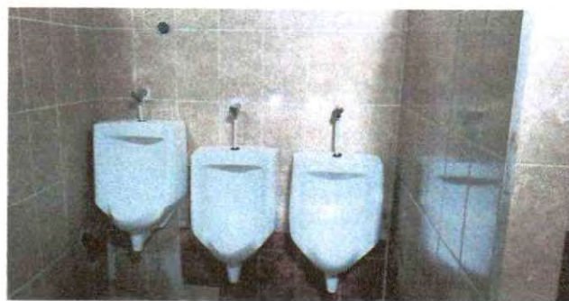
Sustitución de mingitorio hechizo de concreto por 3 mingitorios de porcelana, Con materiales y mano de obra.
