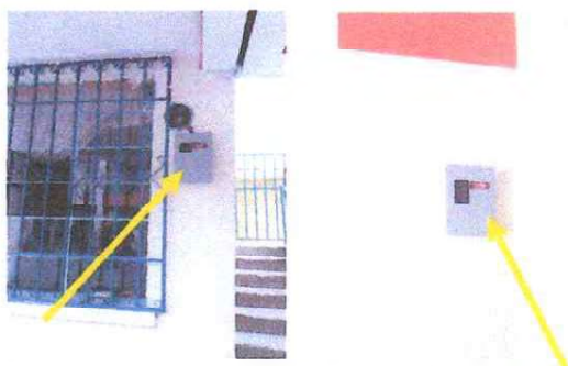
Suministro e instalación de cajas de flípones del sistema general y sustitución de cableado, cambio de plafoneras, interruptores en el sistema eléctrico de baños de niños y niñas.
