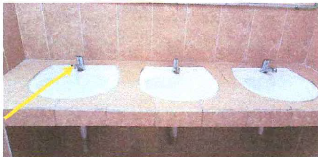
Suministro e instalación de accesorios de 3 lavamanos
