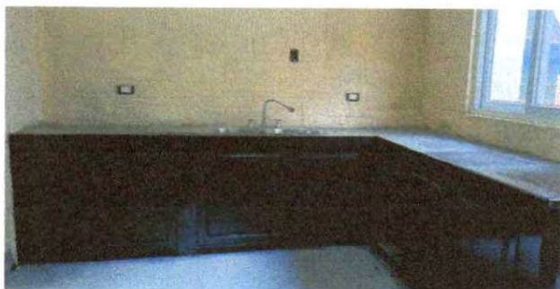
Suministro e instalación de mesas de trabajo para cocina, fundidas de concreto y con acabado de porcelanato con lavatrastos de fosa doble.
