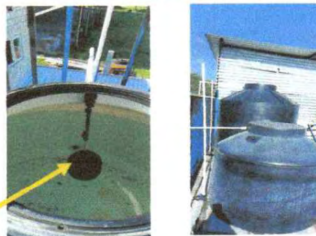
Suministro e instalación de dos depositos de agua, incluyendo sistema de flote nuevo, tapadera de deposito y filtros nuevos para limpieza de agua.
