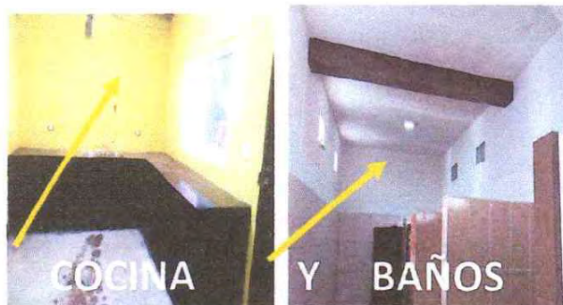
Suministro y aplicación de pintura en paredes internas y externas de cocina y baño.
