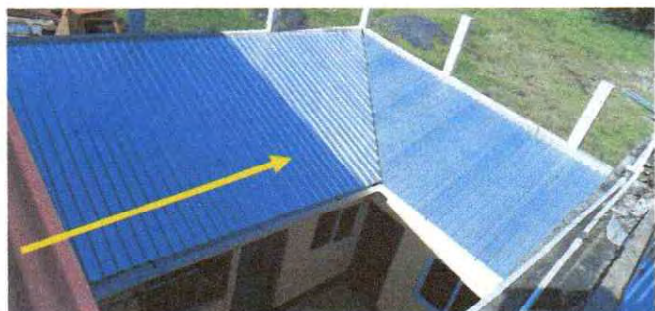
Suministro e instalación de techo de cocina.
