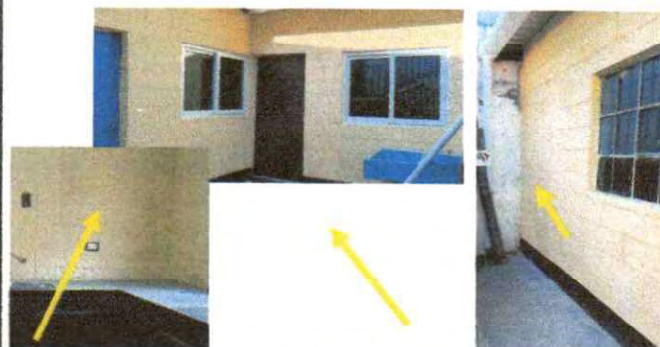
Mantenimiento de muro con sella puerta de acceso a bodega y sellar ventana que da a aula contigua, abertura de vano de puerta y área de cocina, dos ventanas, levantado de 3 hiladas de block más sellado y ventanas en upvc.
