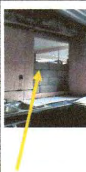
Mantenimiento de muro con sella puerta de acceso a bodega y sellar ventana que da a aula contigua, abertura de vano de puerta y área de cocina, dos ventanas, levantado de 3 hiladas de block más sellado y
