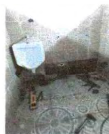
Sustitución de mingitorio hechizo de concreto por 3 mingitorios de porcelana, Con materiales y mano de obra.
