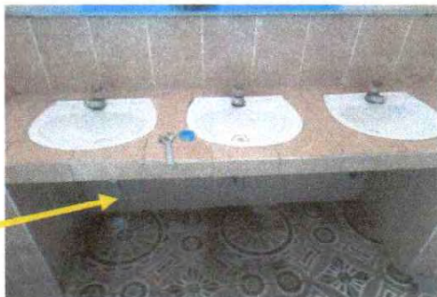
Suministro e instalación de accesorios de 3 lavamanos
