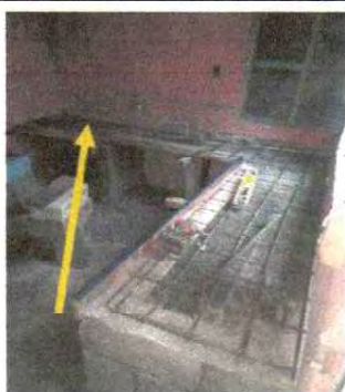
Suministro e instalación de mesas de trabajo para cocina, fundidas de concreto y con acabado de porcelanato con lavatrastos de fosa doble.
