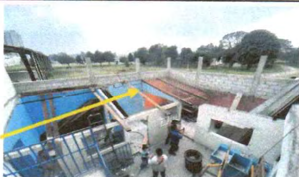
Suministro e instalación de techo de cocina.
