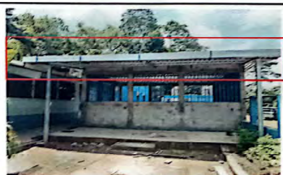
Foto 6: SUSTITUCION DE CANAL DE PVC
