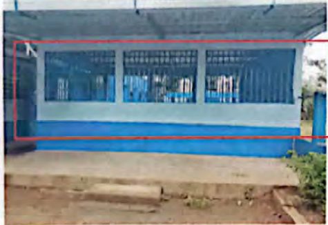
Foto 3: SUSTITUCION MALLA GALVANIZADA POR BALCONES
