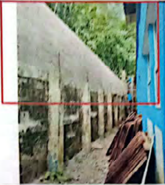
Foto 1: REPARACION DE MURO PERIMETRAL
