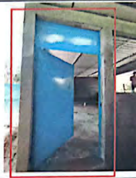
Foto 2: SUSTITUCION DE PUERTA METALICA CON PASADOR
