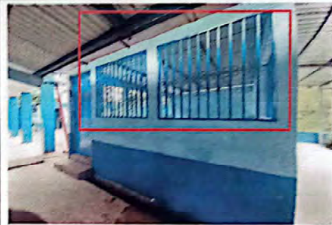
Foto 4: SUSTITUCION MALLA GALVANIZADA POR BALCONES
