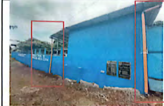
Foto 1: SUSTITUCION DE BAJADAS DE AGUA PLUVIAL DE TUBO DE PVC DE 3"
