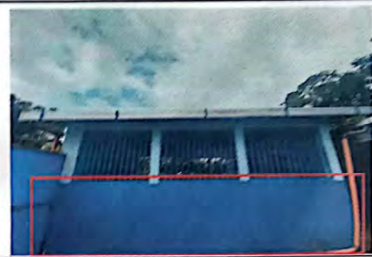
Foto 2: SUSTITUCION MURO DE CONCRETO
