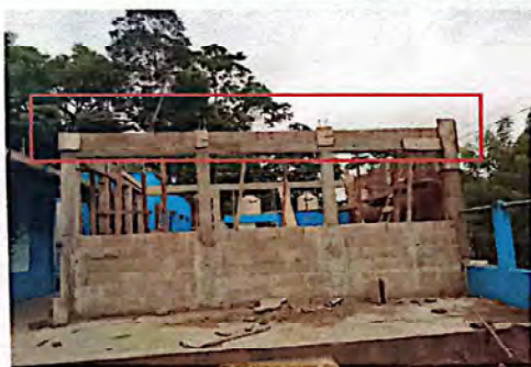
Foto 3: SUSTITUCION LAMINA ZINC POR LAMINA TERNIUM ALUZING TROQUELADA C26
