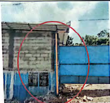
Foto1: SUSTITUCION DE BAJADAS DE AGUA PLUVIL DE TUBO DE PVC DE 3"
