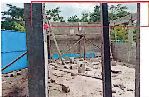
Foto 5: SUSTITUCION DE ESTRUCTURA DE SOPORTE DE MADERA POR ESTRUCTURA DE METAL
