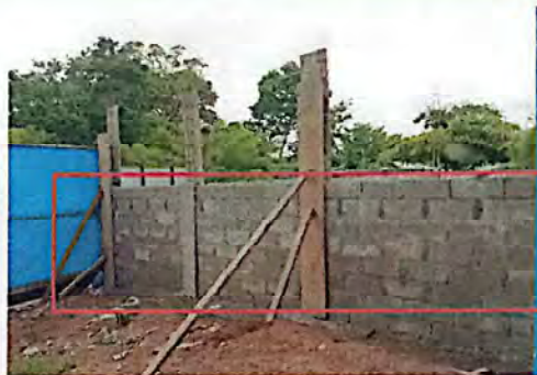
Foto 2: SUSTITUCION MURO DE CONCRETO
