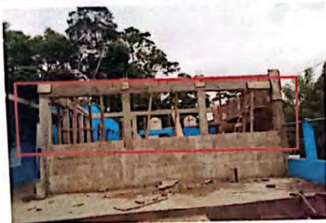
Foto 3: SUSTITUCION MALLA GALVANIZADA POR BALCONES
