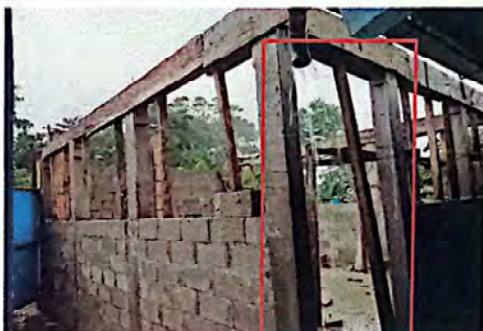
Foto 4: SUSTITUCION MALLA GALVANIZADA POR BALCONES
