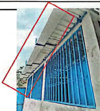
Foto 6: SUSTITUCION DE CANAL DE PVC
