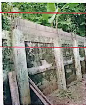
Foto 1: REPARACION DE MURO PERIMETRAL
