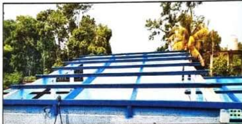
Foto 4: SUMINISTRO Y MANTENIMIENTO A ESTRUCTURA DE METAL CON ANTICORROSIVO
