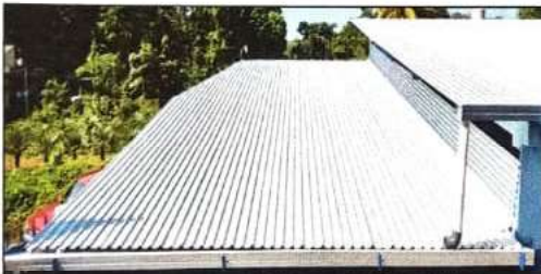
Foto 3: SUMINISTRO Y SUSTITUCION DE LAMINA, POR LAMINA CALIBRE 26
