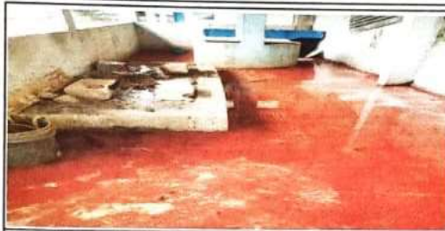
Foto 1: SUMINISTRO Y SUSTITUCION DE PISO DE TORTA DE CONCRETO EN COCINA
