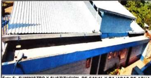
Foto 6: SUMINISTRO Y SUSTITUCION DE CANAL Y BAJADAS DE AGUA PLUVIAL CON TUBO DE 4"
