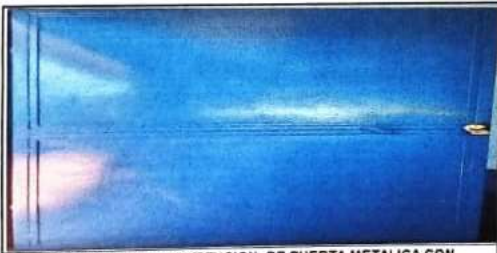
Foto 5: SUMINISTRO Y SUSTITUCION DE PUERTA METALICA CON CHAPA YALE
