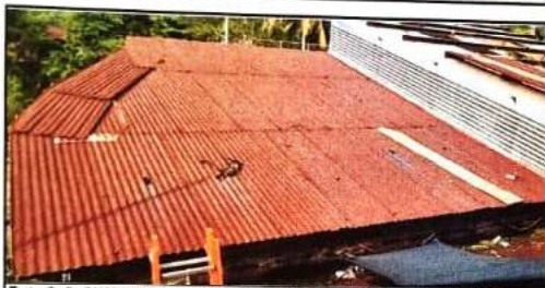
Foto 3: SUMINISTRO Y SUSTITUCION DE LAMINA, POR LAMINA CALIBRE 26
