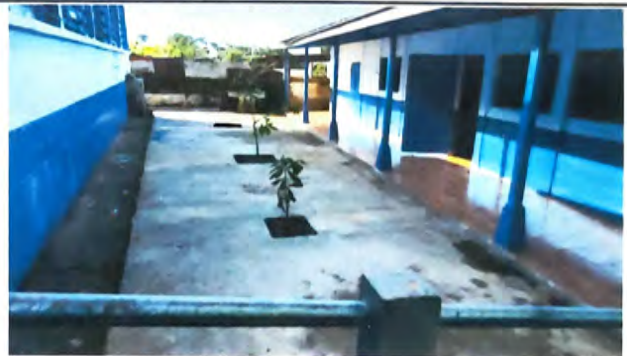
Foto 4: Sustitución de torta de concreto por concreto
