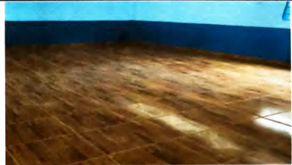
Foto 10: SUSTITUCIÓN DE PISO DE CONCRETO POR PISO CERÁMICO CON BASE DE CONCRETO, módulo 4
