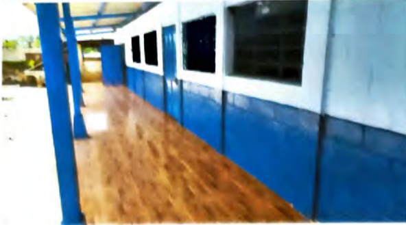
Foto 7: SUSTITUCIÓN DE TORTA DE CONCRETO POR PISO CERAMICO
