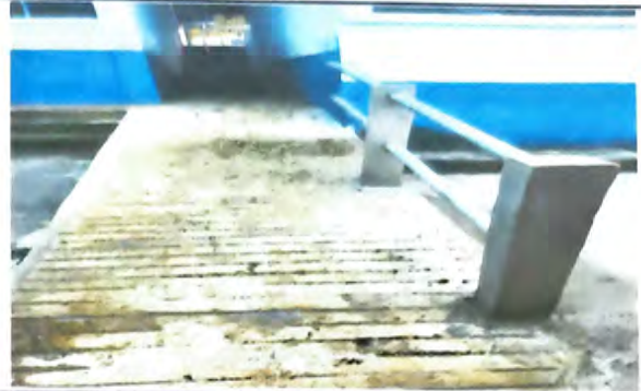
Foto 2: Sustitución de rampas 2 de concreto
