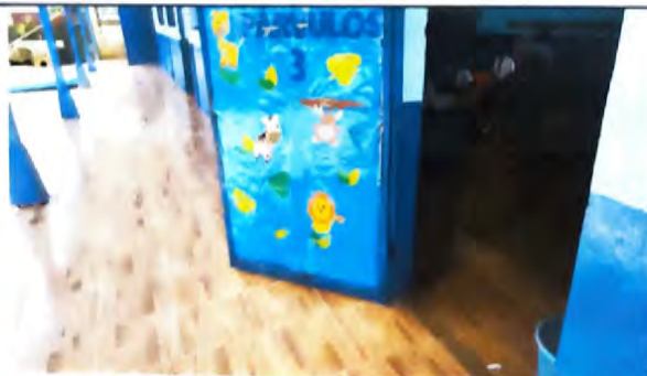
Foto 5: Instalación de piso cerámico
