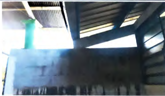
Foto 3: Reparación Muro perimetral
