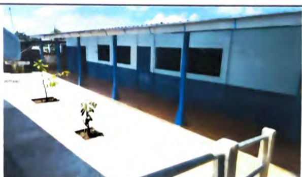
Foto 6: Instalación de ventanas
