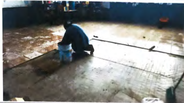
Foto 10: SUSTITUCIÓN DE PISO DE CONCRETO POR PISO CERÁMICO CON BASE DE CONCRETO, módulo 4
