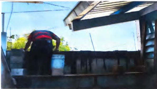
Foto 3: Reparación Muro perimetral
