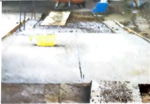
Foto 1: Sustrucción de rampas de concreto
