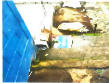
Foto 2: Sustrucción de rampas 2 de concreto
