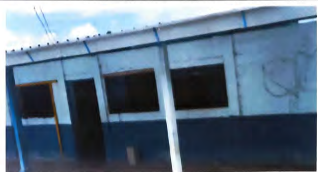
Foto 6: Instalación de ventanas
