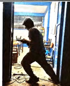
Foto 2: REPARACION DE PUERTA DE METAL
