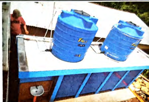
Foto 2: SUSTITUCION DE DEPOSITO DE AGUA EN SANITARIOS
