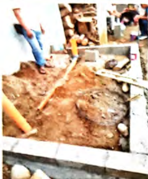
Foto 1: SUSTITUCION DE DRENAJE EN SANITARIOS
