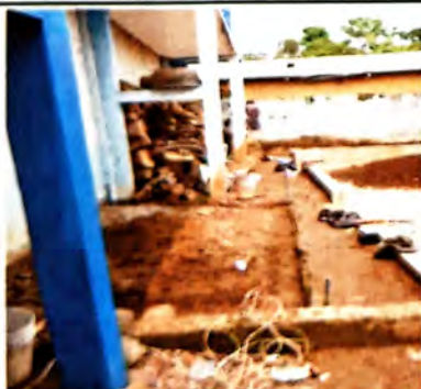
Foto 5: SUSTITUCION DE PLANCHA DE CONCRETO
