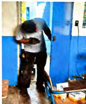
Foto1: REPARACION DE PUERTA DE METAL
