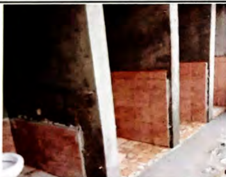
Foto 3: SUSTITUCION DE AZULEJOS EN SANITARIOS
