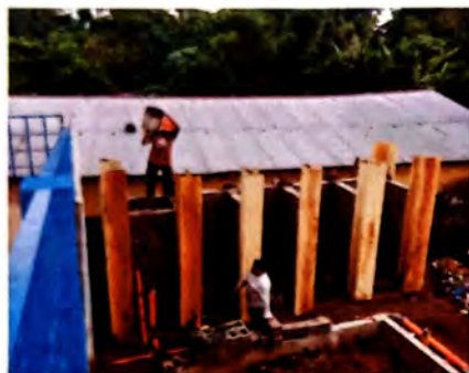
Foto 1: SUSTITUCION DE MURO DE BLOCK EN SANITARIOS
