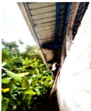
Foto 3: SUSTITUCION DE CANAL
