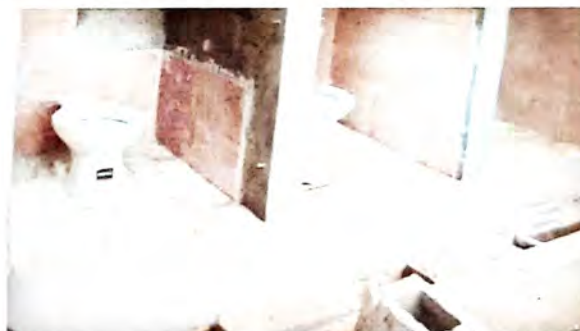
Foto 4: SUSTITUCION TORTA DE CONCRETO POR PISO CERAMICO EN SANITARIOS
