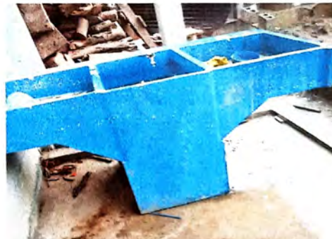
Foto 4: SUSTITUCION PILA DE CONCRETO DE DOS ALAS
