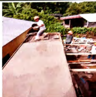
Foto 2: SUSTITUCION DE LOSA EN SANITARIOS
