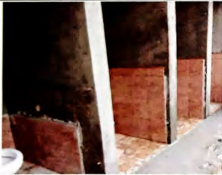
Foto 3: SUSTITUCION DE AZULEJOS EN SANITARIOS
