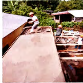
Foto 2: SUSTITUCION DE LOSA EN SANITARIOS
