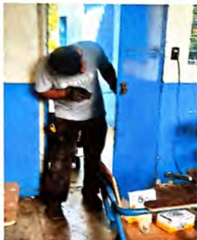
Foto1: REPARACION DE PUERTA DE METAL
