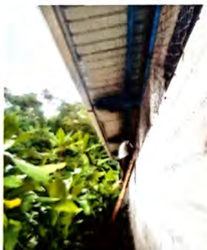
Foto 3: SUSTITUCION DE CANAL
