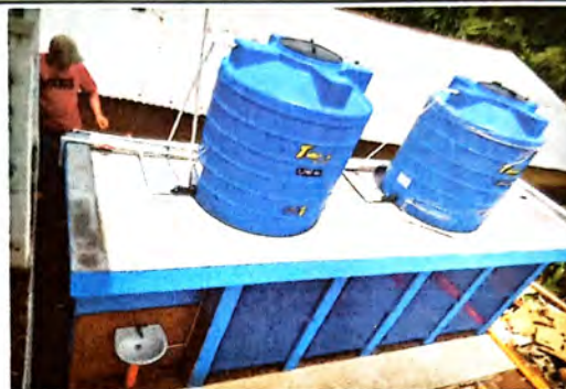
Foto 2: SUSTITUCION DE DEPOSITO DE AGUA EN SANITARIOS
