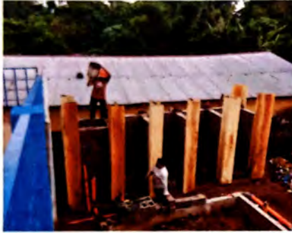
Foto 1: SUSTITUCION DE MURO DE BLOCK EN SANITARIOS
