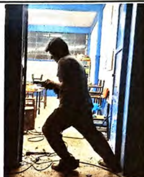
Foto 2: REPARACION DE PUERTA DE METAL
