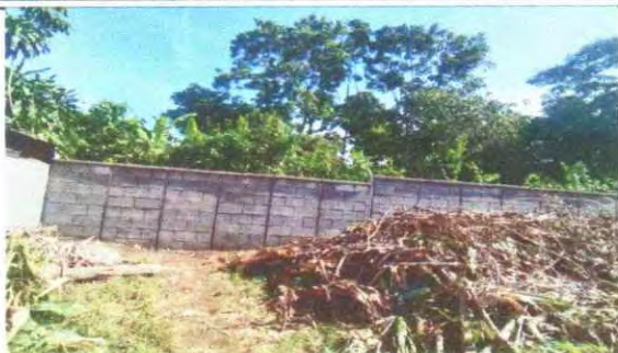
Foto 1: Instalacion de muro perimetral pre-fabricado
