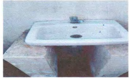
FOTO 8 : SUSTITUCION DE ACCESORIOS PARA SANITARIOS Y LAVAMANOS
