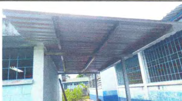
Foto 4: Mantenimiento de estructura para soporte de lámina
