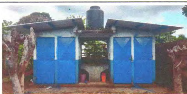
Foto 5: Instalacion de lamina troquelada calibre 26
