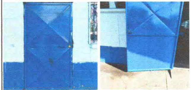
Foto 10: INSTALACION DE CHAPAS EN PUERTAS DE METAL
