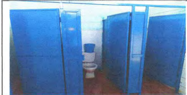
Foto 12: SUSTITUCION DE DIVISION DE METAL EN SANITARIO
