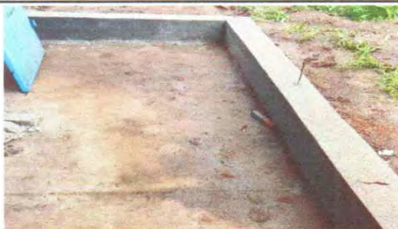
foto 3 : Instalacion de muro de concreto
