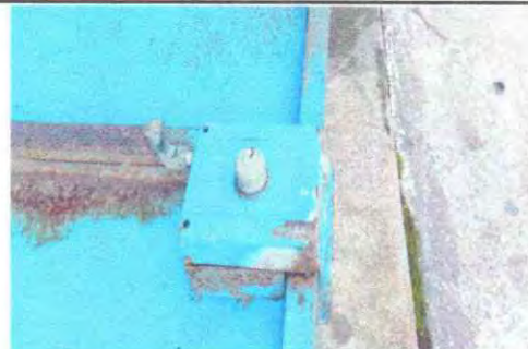
Foto 10: INSTALACION DE CHAPAS EN PUERTAS DE METAL
