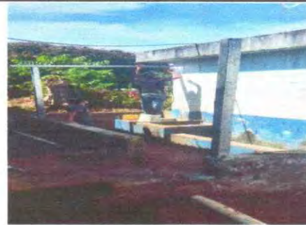
Foto 4: Mantenimiento de estructura para soporte de lámina
