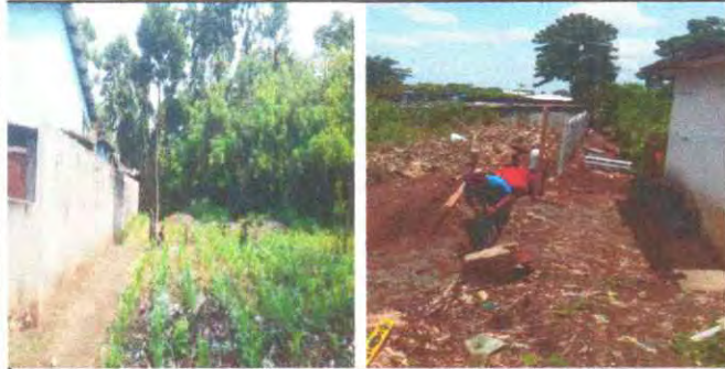
Foto 1: Instalacion de muro perimetral pre-fabricado
