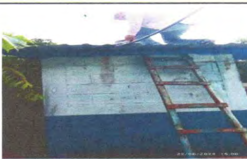
Foto 5: Instalacion de lamina troquelada calibre 26
