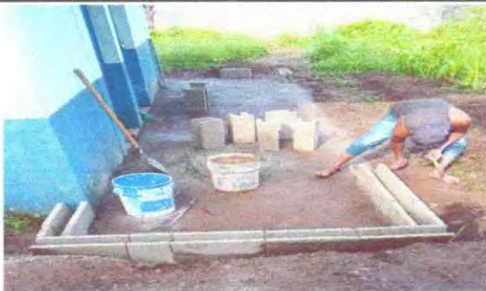
Foto 3 : Instalacion de muro de concreto
