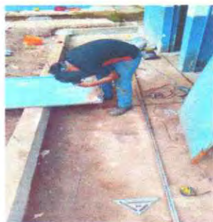
Foto 7: MANTENIMIENTO DE PUERTAS DE METAL, APLICACIÓN DE PINTURA.
