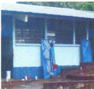
Foto 7: MANTENIMIENTO DE PUERTAS DE METAL, APLICACIÓN DE PINTURA.
