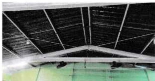
Foto 5: Mantenimiento a sistema electrico de salón
