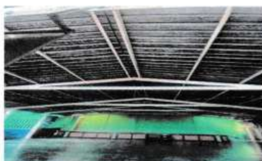
Foto 2: Instalacion de base o estructura para cubierta de lamina (paloma)
