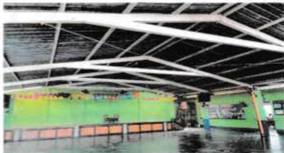
Foto 1: Mantenimiento a estructura de soporte de cubierta de metal, lijado y aplicación de pintura.
