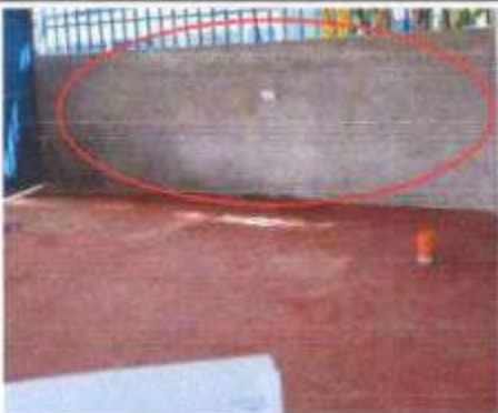
Foto 1: REPELLO, CERNIDO EN PAREDES DE COCINA, REPARACION DE MUROS.
