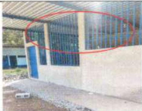
Foto 5: SUSTITUCION DE BALCONES EN COCINA.
