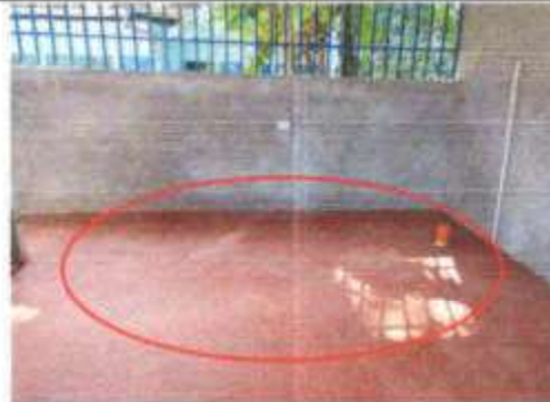
Foto 2: SUSTITUCION DE PISO DE CONCRETO DE COCINA POR PISO LISO.
