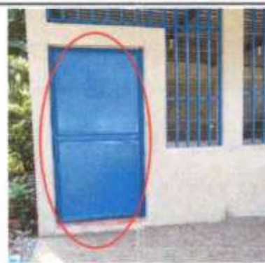
Foto 4: SUSTITUCION DE PUERTA DE MADERA POR METAL EN COCINA.
