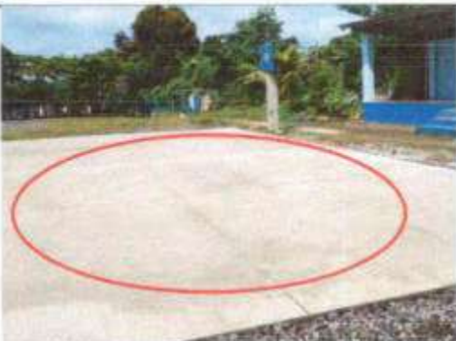
Foto 3: SUSTITUCION DE TORTA DE CONCRETO EN PATIO
