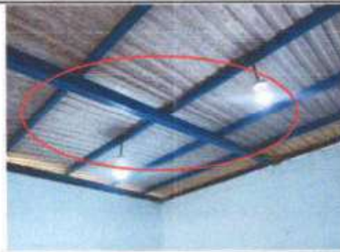
Foto 6: REPARACIÓN DE SISTEMA ELECTRICO
