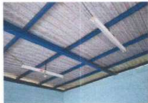
Foto 6: REPARACIÓN DE SISTEMA ELECTRICO
