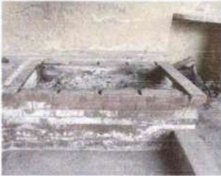
Foto 7: SUSTITUCIÓN DE ESTUFA RURAL CON CHIMENEA Y PLANCHA DE METAL.
