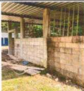
Foto 5: SUSTITUCION DE BALCONES EN COCINA.
