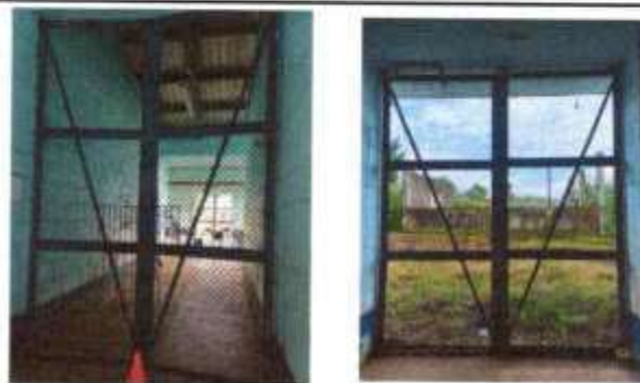
Foto 6: SUMINISTRO Y SUSTITUCION DE PORTON DE METAL
