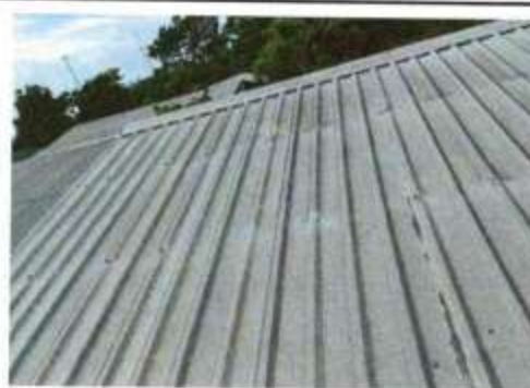
Foto 2: SUSTITUCIÓN DE LAMINA TROQUELADA ALUZIN C26
