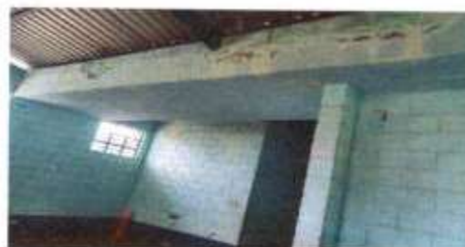
Foto 4: APLICACIÓN DE PINTURA LATEX CLASICA
