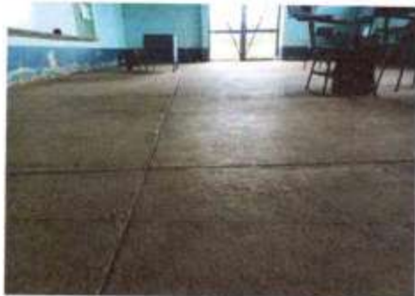
Foto1: SUMINISTRO E INSTALACIÓN DE PISO CERÁMICO
