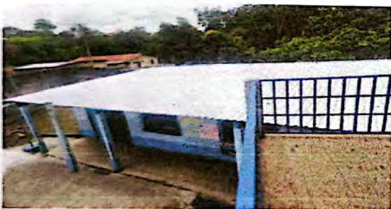
Foto 9: Suministro y Sustitución de lámina, por lamina troquelada Calibre 26 en aulas Finalizado
