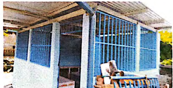
Foto 4: Suministro y Sustitución de malla por balcones de metal Finalizado
