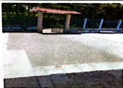
Foto 17: Suministro y sustitución de torta de cemento en patio 40 m2 Finalizado
