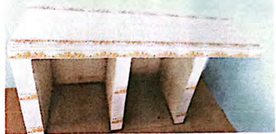
Foto 2: Suministro y Reparación de mesa de trabajo en cocina 2 x 0.60 x 0.90 M Finalizado
