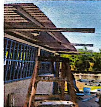
Foto 10: Suministro y sustitución de lámina acanalada por lámina acanalada c26 en cocina desinstalado
