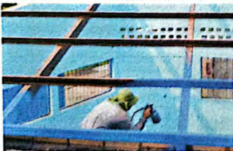
Foto 11: Suministro y Mantenimiento de estructura de metal de módulo de 2 aulas aplicando pintura
