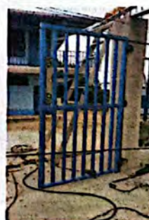
Foto 6: Suministro y Sustitución de portón de metal de 2 x 2.5 M instalando
