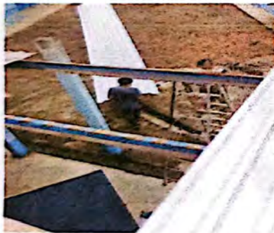
Foto 9: Suministro y Sustitución de lámina, por lamina troquelada Calibre 26 en aulas desinstalado techo
