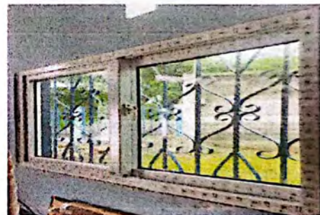
Foto 22: Suministro e instalación de ventana PVC de 1.05 x 1.60 m Instalado
