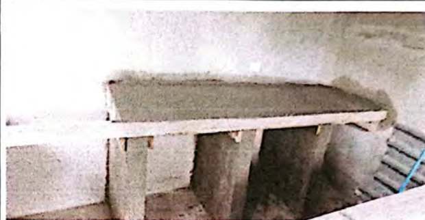
Foto 2: Suministro y Reparación de mesa de trabajo en cocina 2 x 0.80 x 0.90 M En construcción
