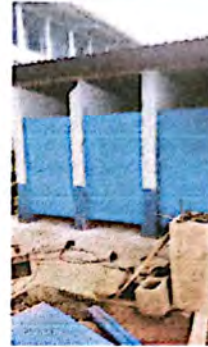
Foto 8: Suministro y Sustitución de puerta de metal en sanitarios instaladas
