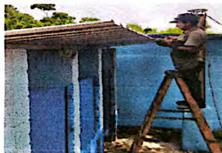
Foto 16: Suministro, desinstalación e instalación de lámina acanalada por lamina troquelada en sanitario instalado el techo
