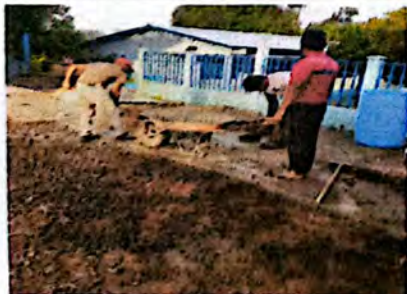
Foto 17: Suministro y sustitución de torta de cemento en patio 40 m2 levantando pavimento antiguo
