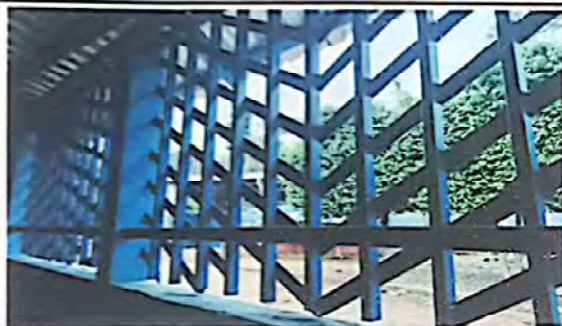
FOTO 3: MANTENIMIENTO DE BALCONES
