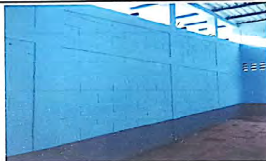
FOTO 4: APLICACIÓN DE PINTURA EXTERIOR E INTERIOR EN MUROS
