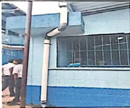
FOTO 9: SUSTITUCION DE BAJADA DE AGUA PLUVIAL
