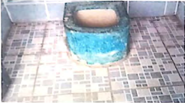
FOTO 7: INSTALACION DE PISO CERAMICO EN SERVICIOS SANITARIOS
