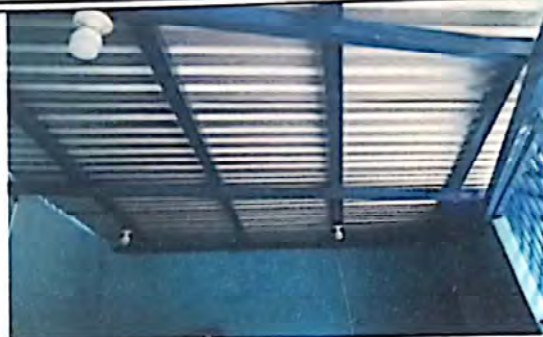
FOTO 2: SUSTITUCION DE ESTRUCTURA DE SOPORTE DE MADERA POR METAL Y SUSTITUCION DE LAMINA POR LAMINA CALIBRE 26 EN DIRECCION
