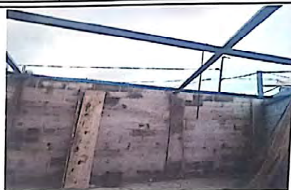
FOTO 2: SUSTITUCION DE ESTRUCTURA DE SOPORTE DE MADERA POR METAL Y SUSTITUCION DE LAMINA POR LAMINA CALIBRE 26 EN DIRECCION
