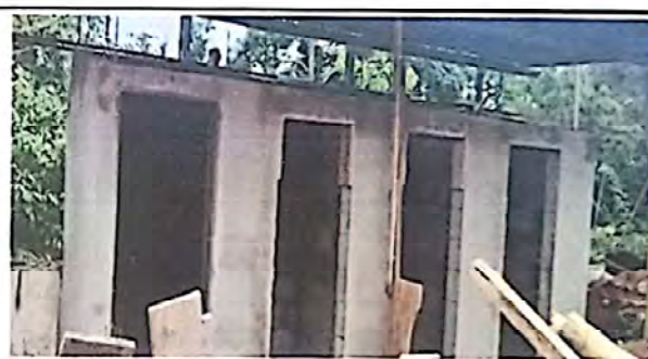
FOTO 6: FABRICACION E INSTALACION DE PUERTA DE METAL EN SERVICIOS SANITARIOS
