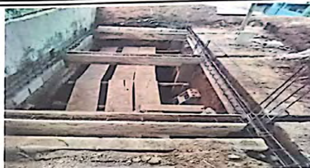
FOTO 8: MANTENIMIENTO DE MIGITORIO Y TAPA DE FOSA
