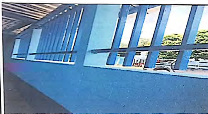
FOTO 3: MANTENIMIENTO DE BALCONES
