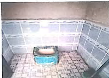
FOTO 5: INSTALACION DE AZULEJO EN SERVICIOS SANITARIOS
