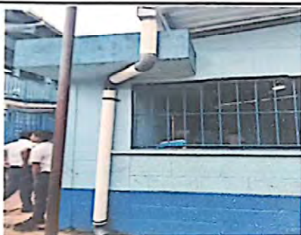
FOTO 9: SUSTITUCION DE BAJADA DE AGUA PLUVIAL
