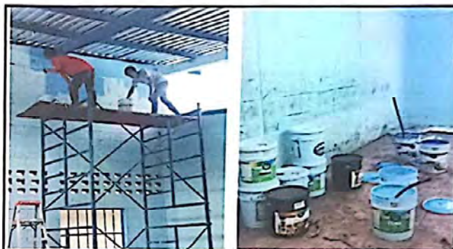
FOTO 4: APLICACIÓN DE PINTURA EXTERIOR E INTERIOR EN MUROS
