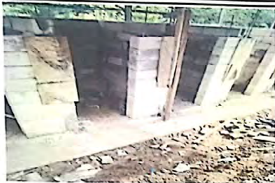
FOTO 1: SUSTITUCION DE MURO EN SERVICIOS SANITARIOS
