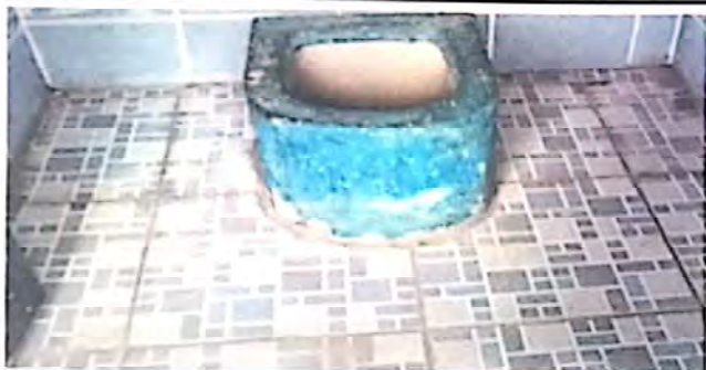
FOTO 7: INSTALACION DE PISO CERAMICO EN SERVICIOS SANITARIOS
