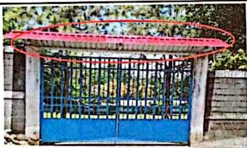
FOTO 3: INSTALACION DE ESTRUCTURA DE SOPORTE DE LAMINA E INSTALACION DE LAMINA EN PORTON DE INGRESO
