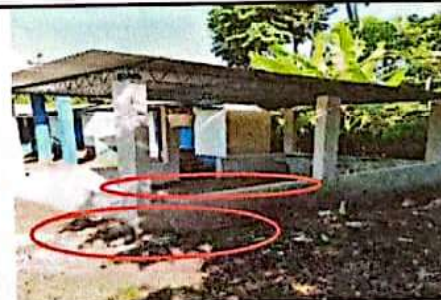
FOTO 6: INSTALACIÓN DE MURO DE CONCRETO E INSTALACIÓN DE TORTA DE CONCRETO EN PILAS
