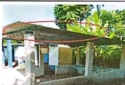
FOTO 8: SUSTITUCION DE LAMINA POR LAMINA ACANALADA EN PILAS
