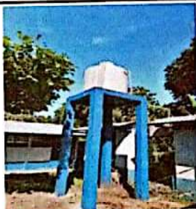
FOTO 5: FABRICACION DE BASE PARA DEPOSITO DE AGUA, INSTALACION DE DEPOSITO DE AGUA, APLICACIÓN PINTURA A BASE CONCRETO EN SANITARIOS
