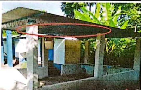
FOTO 7: SUSTITUCION DE ESTRUCTURA DE MADERA POR ESTRUCTURA DE METAL EN PILAS
