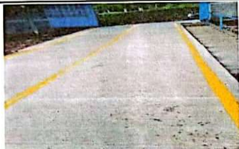
FOTO 1: INSTALACIÓN DE EMPEDRADO Y TORTA DE CONCRETO, REPARACION DE GRADAS E INSTALACION DE PASA MANOS
