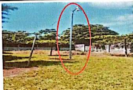
FOTO 4: AREA PARA INSTALAR LAMPARAS DE ILUMINACIÓN INTERIOR EN CENTRO EDUCATIVO
