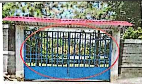
FOTO 2: MANTENIMIENTO DE PORTON DE METAL DE INGRESO AL CENTRO EDUCATIVO
