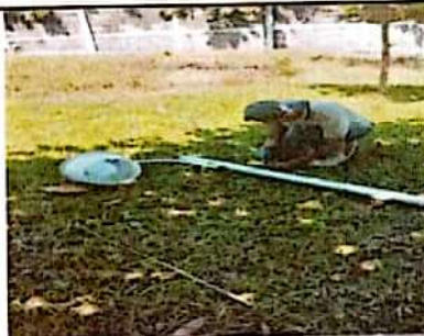
FOTO 4: AREA PARA INSTALAR LAMPARAS DE ILUMINACIÓN INTERIOR EN CENTRO EDUCATIVO
