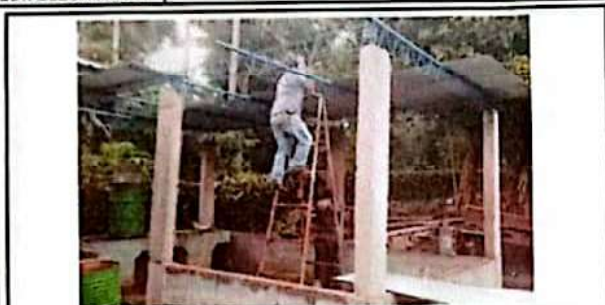
FOTO 7: SUSTITUCION DE ESTRUCTURA DE MADERA POR ESTRUCTURA DE METAL EN PILAS
