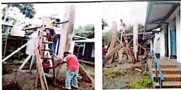
FOTO 5: FABRICACION DE BASE PARA DEPOSITO DE AGUA, INSTALACION DE DEPOSITO DE AGUA, APLICACIÓN PINTURA A BASE CONCRETO EN SANITARIOS
