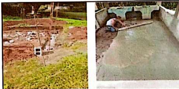
FOTO 6: INSTALACIÓN DE MURO DE CONCRETO E INSTALACIÓN DE TORTA DE CONCRETO EN PILAS
