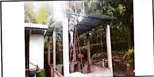
FOTO 8: SUSTITUCION DE LAMINA POR LAMINA ACANALADA EN PILAS
